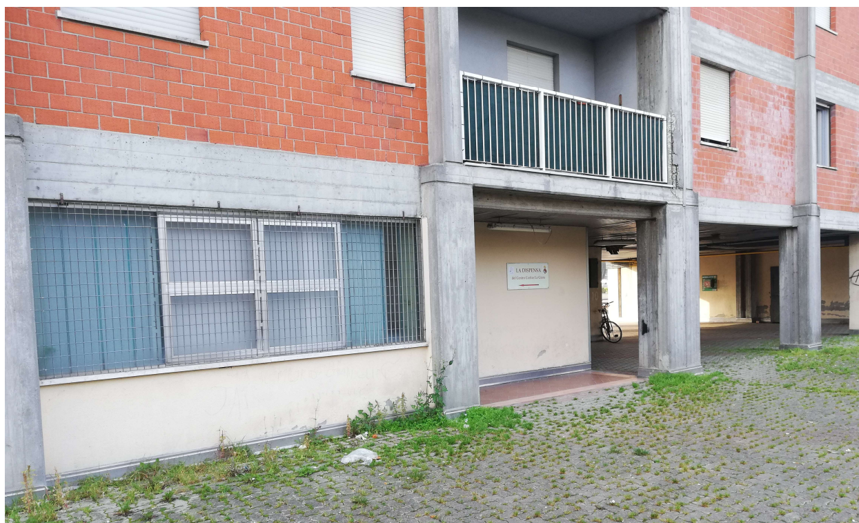
Figura 16: Vista piano pilotis dall'area cortilizia
