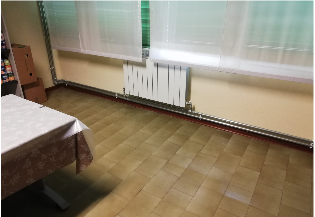
Figura 17: Vista di locale "La Giara"
