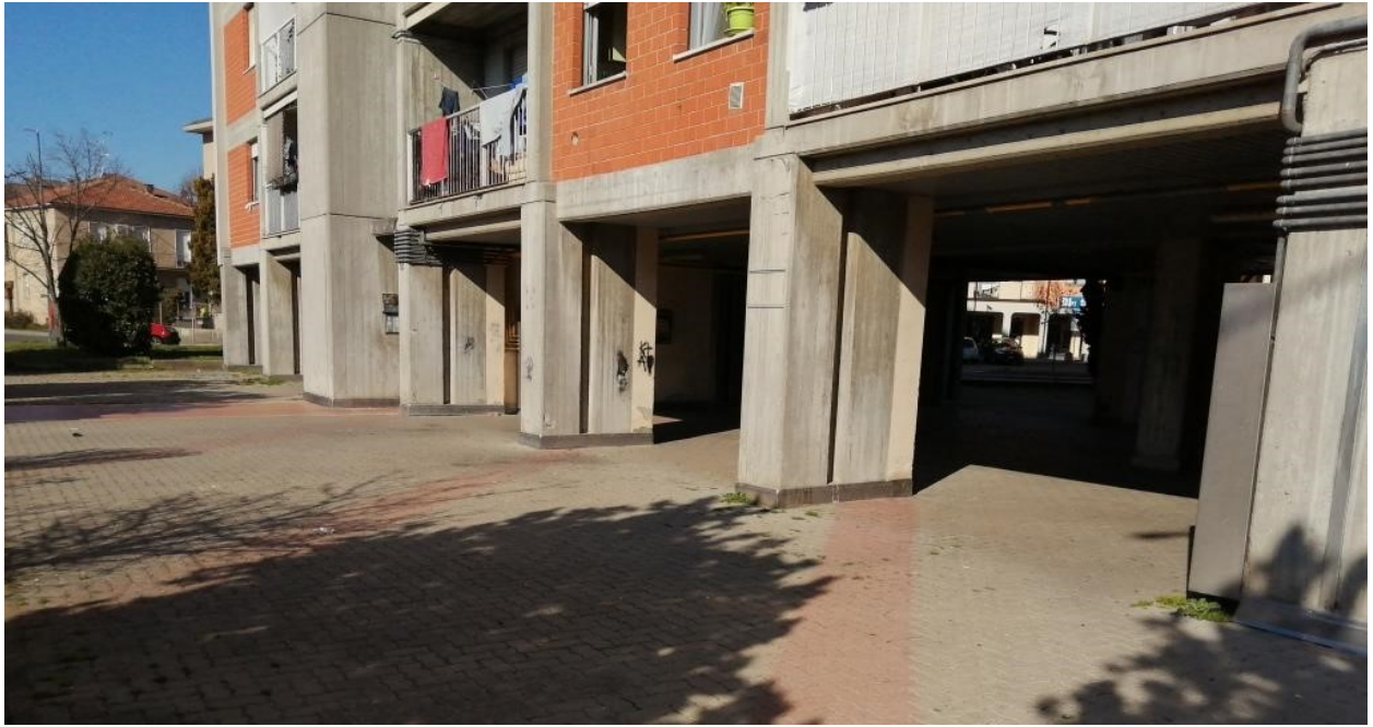
Figura 19: Vista esterna dei pilotis
