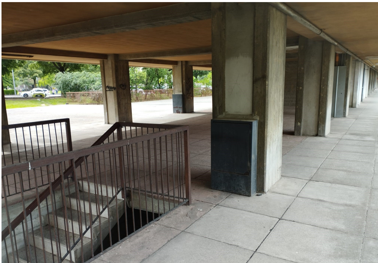
Figura 21: Piano pilotis di via Marinai 1-3
