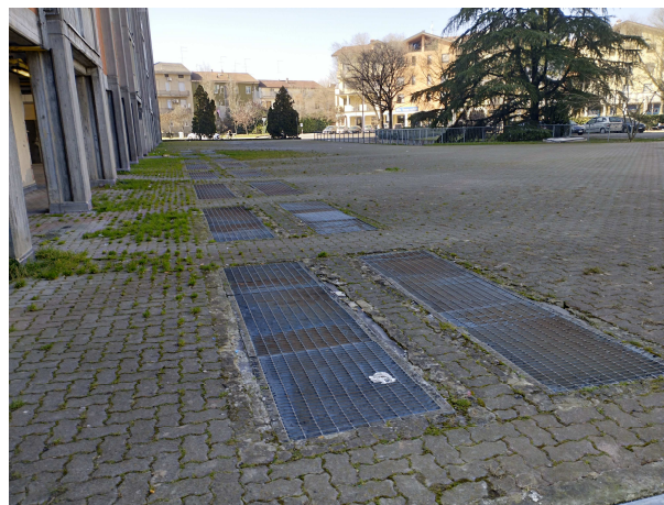
Cortile condominiale palazzina in via Radini Tedeschi n. 87/93
