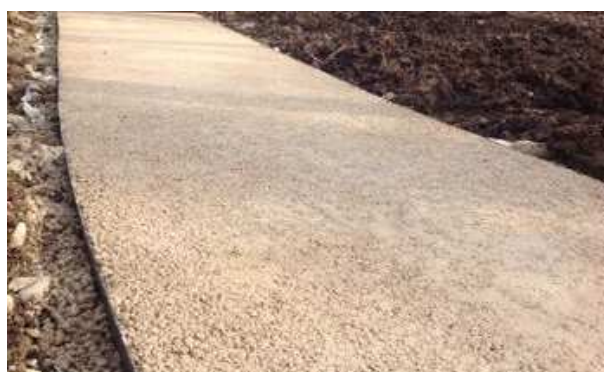
Pavimentazione drenante effetto terra battuta
