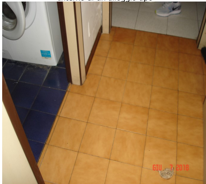
Interno di un alloggio tipo
